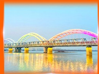
สะพานรถไฟผืนโจว
