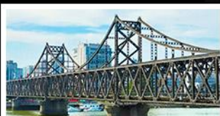
สะพานหวาดตานตง
